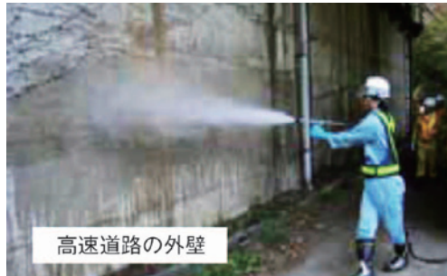
⑦ウルトラファインバブルによる高速道路の橋脚外壁の洗浄 (写真提供: NEXCO西日本)
