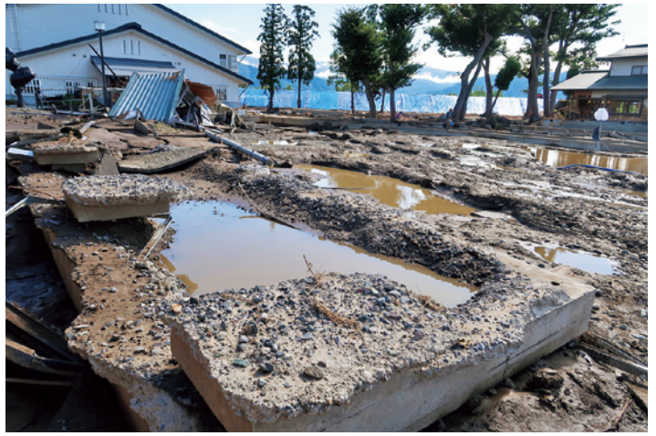
流失して基礎だけになった家（令和元年台風19号・長野市。山村氏撮影）
