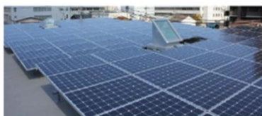
光ダクトと太陽光発電パネル
