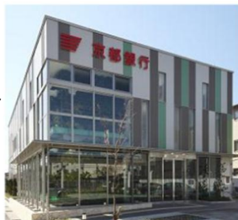
東長岡支店 外観
