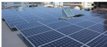
光ダクトと太陽光発電パネル
