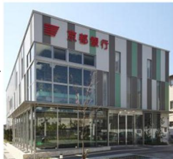
東長岡支店 外観
