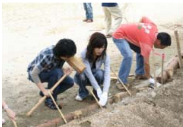
竹杭の打ち込み作業
