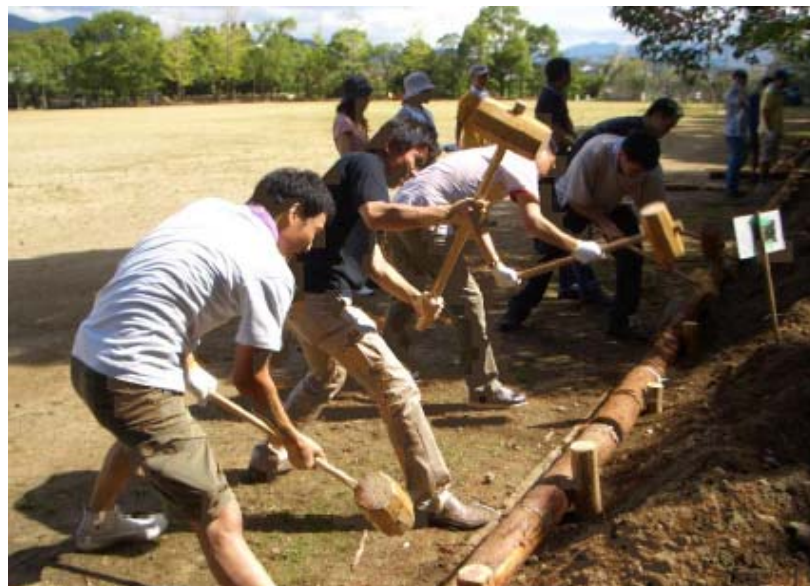
カケヤによる杭打ち作業
