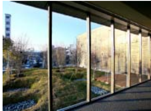
堅田支店の屋上緑化
