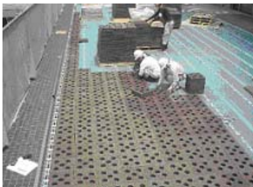
③ 本店屋上緑化の作業風景
